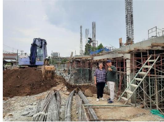
Gambar 12. Pekerjaan dak dilanjutkan pemasangan kolom lantai 2
