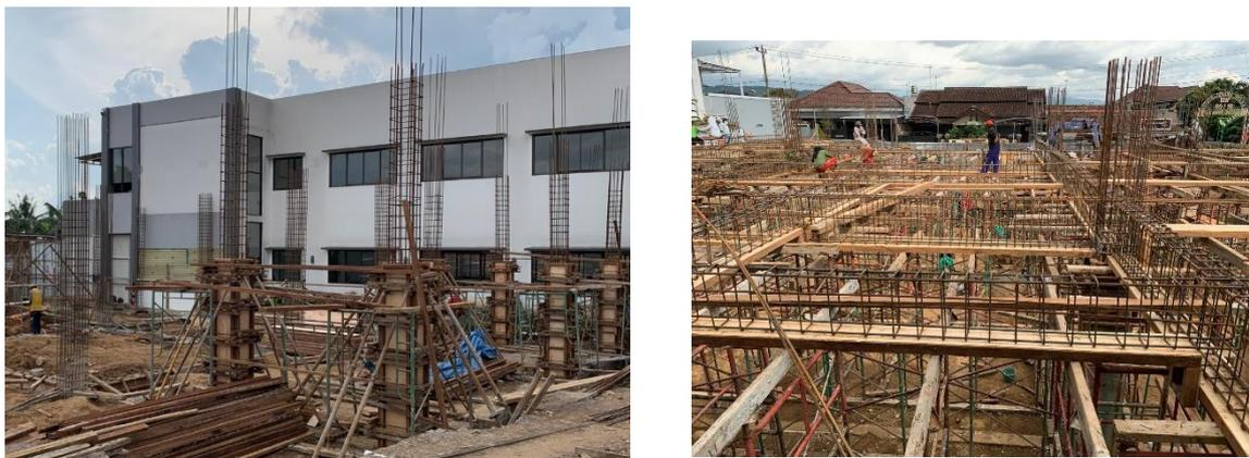
Gambar 11. Gambar Pembesian kolom, balok, dan plat dak
