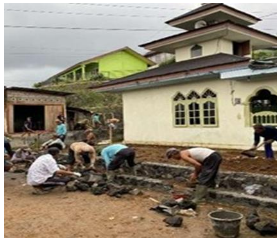
Dokumen Pribadi Gambar 3. Pembuatan Pondasi
