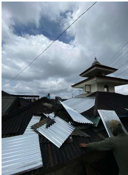
Dokumen Pribadi Gambar 6. Proses Penggantian Atap dan Pemasangan Kanopi
