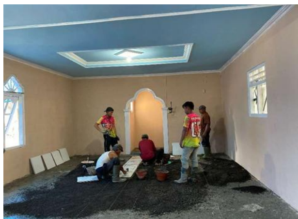
Dokumen Pribadi Gambar 7. Pemasangan Keramik
