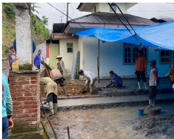
Dokumen Pribadi Gambar 4. Proses Pengecoran
