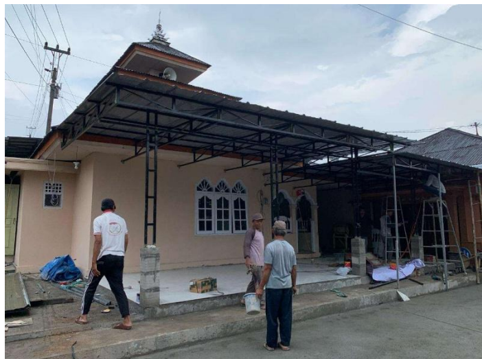
Dokumen Pribadi Gambar 6. Proses Penggantian Atap dan Pemasangan Kanopi
